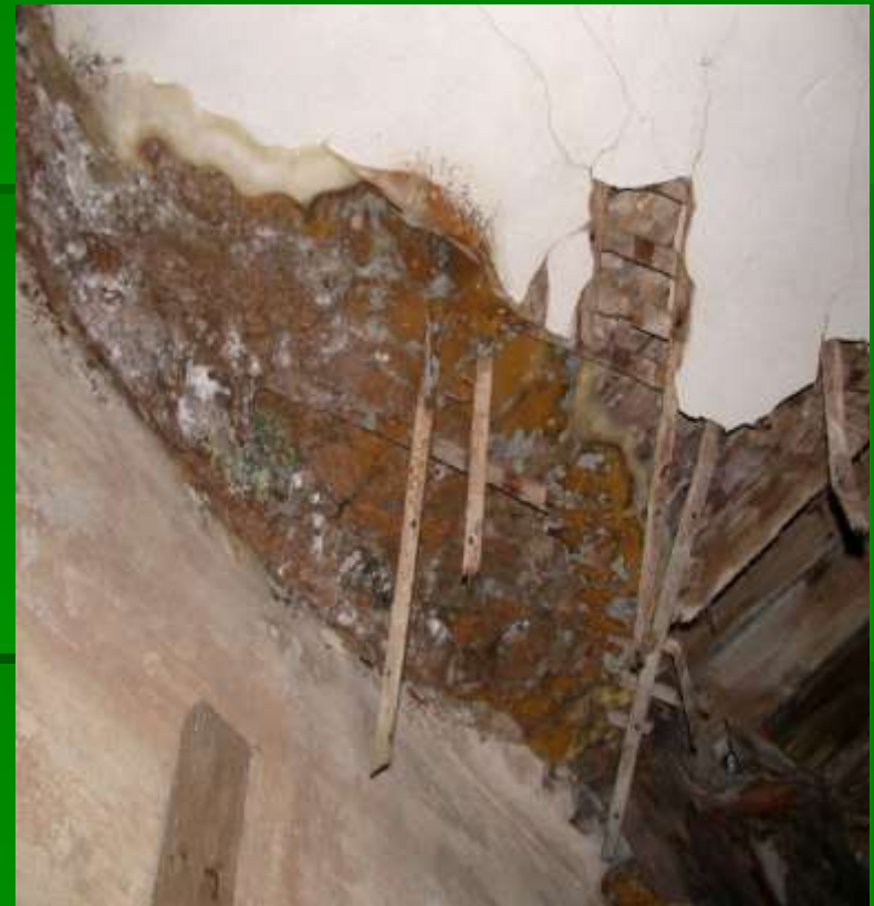
Medinių konstrukcijų biopažeidimai
